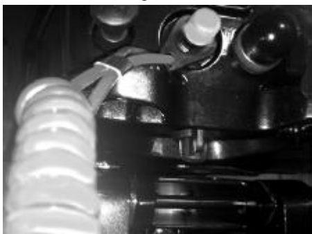
Tanque de Combustible Interno
